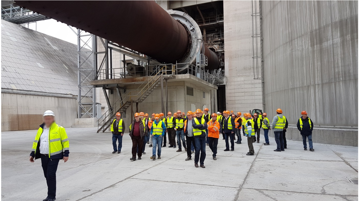
Drehrohrofen im Zementwerk Rohrdorf
