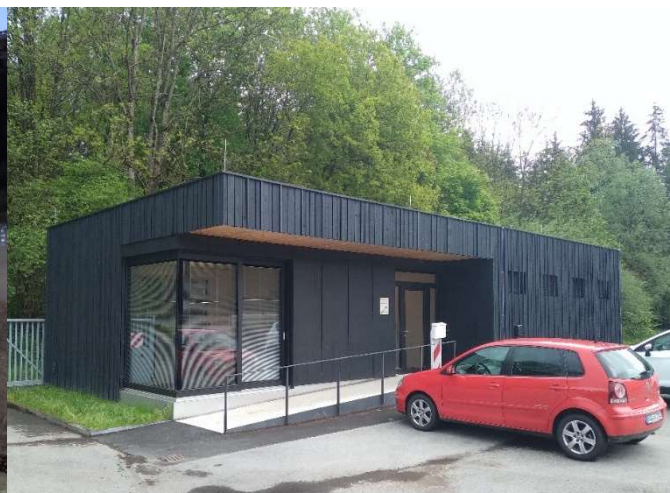
Neues Sozialgebäude in Eiselfing als Ersatz für die alten Bürocontainer
